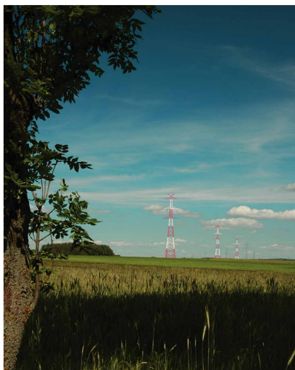
Słupy linii 400 kV
